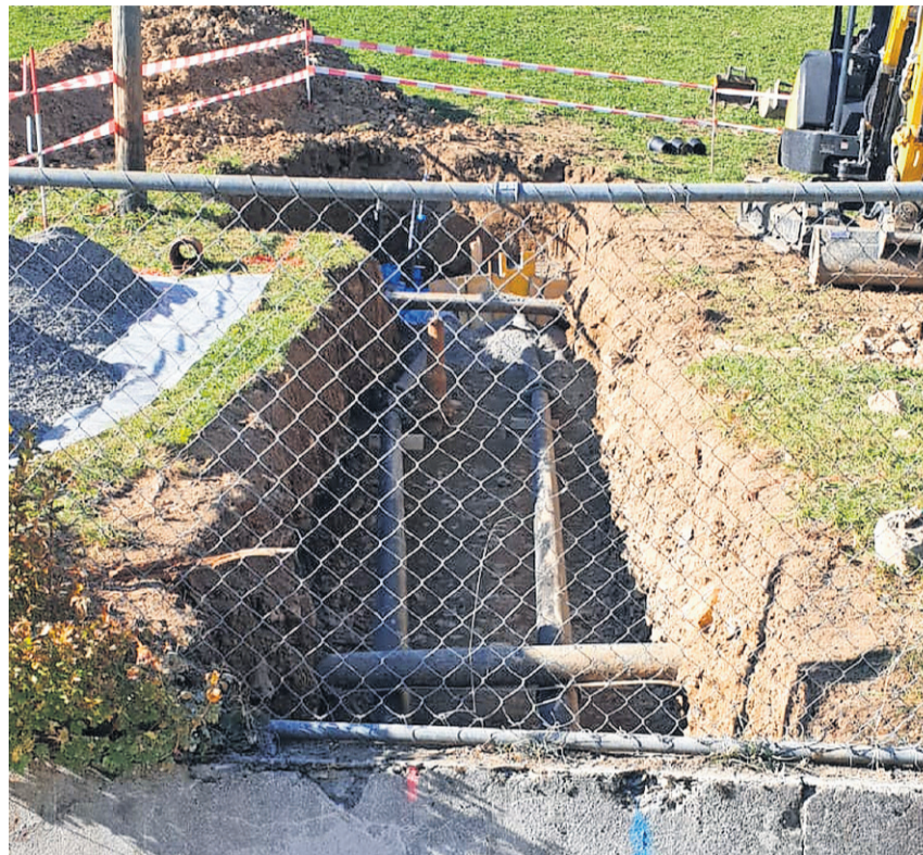
Links: Installation für die Notversorgung von der Quelle Gambach FOTO: ZVG
